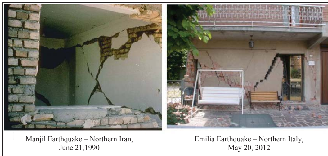
شکل ۹-۱- بروز ترک‌های قطری در دیوارهای بنایی غیرمسلح در زلزله‌های منجیل و امیلیا
