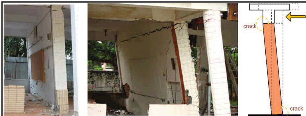
شکل ۱-۲- ایجاد مفصل پلاستیک ترد و بروز ترک‌های افقی در بالا و پایین دیوار به دلیل اتصال گیردار دیوار به دیافراگم‌های کف [۶]
